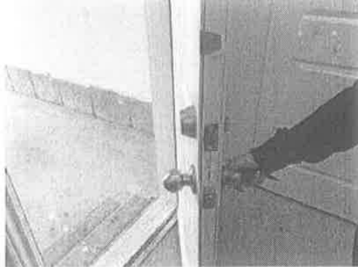
153386 - 1 - TRIM~CRACKED MAN DOOR AT HINGE
