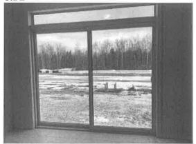
155444 - 2 - WINDOWS~SCREEN DOOR NOT INSTALLED AT SLIDING DOOR 2) INSPECT SCRATCH ON OPERATING SLIDING DOOR LEFT SIDE
